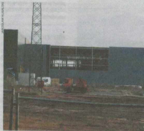
7 kwietnia prace przy inwestycji w Promniku zostały wstrzymane, prowadzone są tylko roboty zabezpieczające
